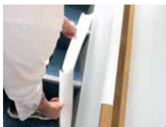
4. 残りの剥離紙を全て剥がす
